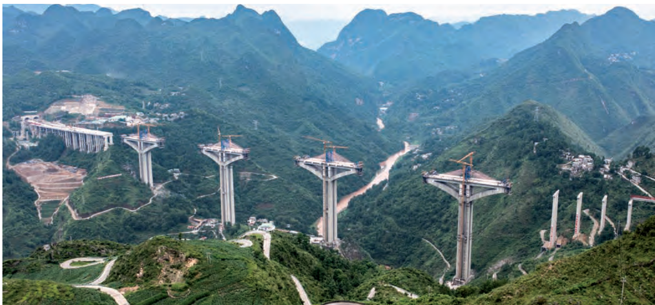
Gran Puente Liuzhi en la autopista Nayong-Qinglong en Liupanshui, Guizhou, el Puente más moderno de los 30.000 que se han construido en Guizhou, para eliminar los cuellos de botella de la conectividad de infraestructura de la única provincia china sin terreno plano (Xinhua/Tao Liang).
