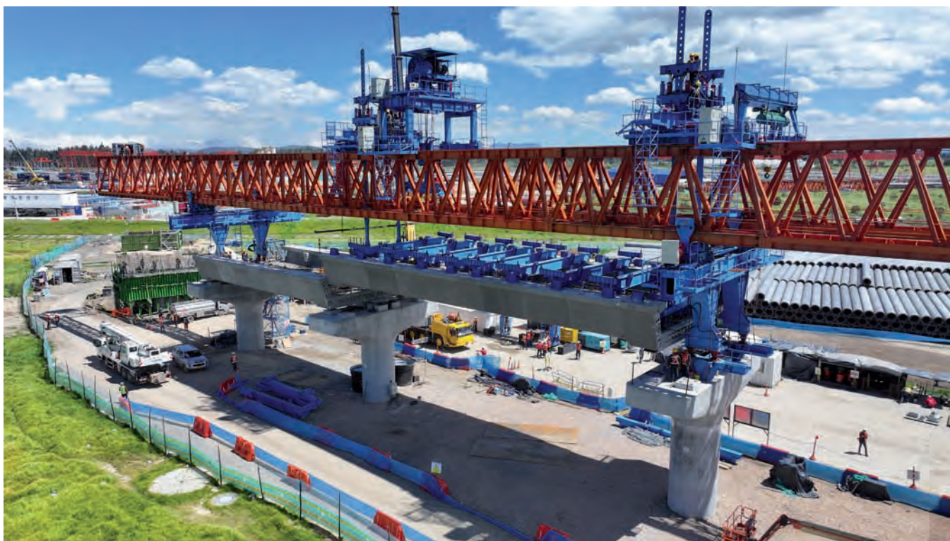
Desarrollo de la obra del metro de Bogotá (foto Metro Línea 1).
