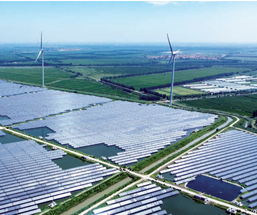
Central de energía fotovoltaica en Tianjin.
