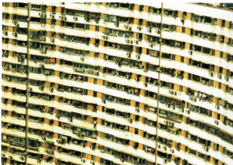
Nuevas viviendas para el pueblo de Shengzhen
