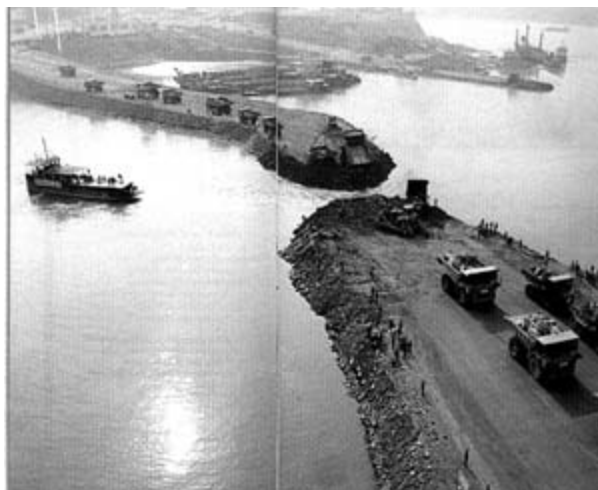
Shenzhen, en sus comienzos. Obra de Terraplén
