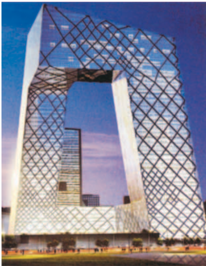
El nuevo edificio de la televisión China, diseñado por Rem Koolhaas, un ícono de la modernidad
